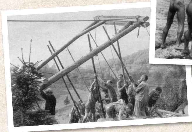
Bau der Materialeiseilbahn auf den Eibel, 1948
